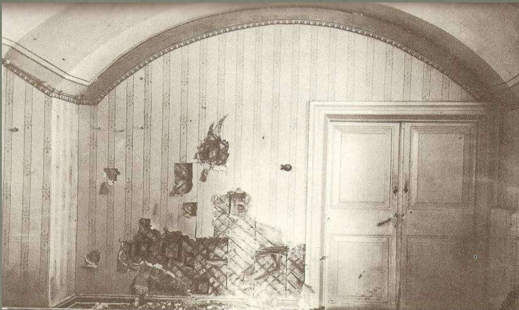
Полуподвальная комната в Ипатьевском доме, где была расстреляна Царская семья.
